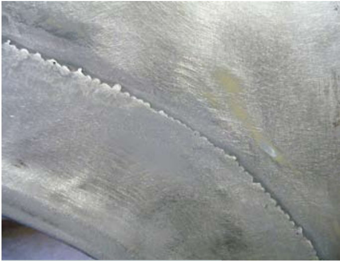
De lasnaden worden met staalplamuur van het merk Debrasel afgewerkt. Dit heeft een etsende werking en is enorm sterk.
